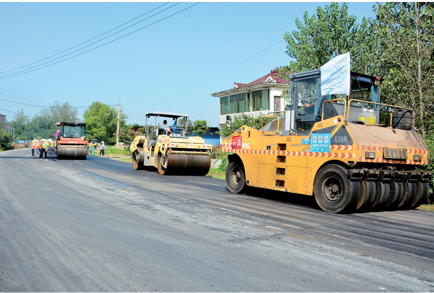
近日，固始县公路事业发展中心紧盯工程项目时间节点，加快推进路线全长 9.678 公里的 S337 线陈淋子镇至祖师庙镇段改建工程上层油面摊铺，力争提前 2 个月全面完成该项目建设。
