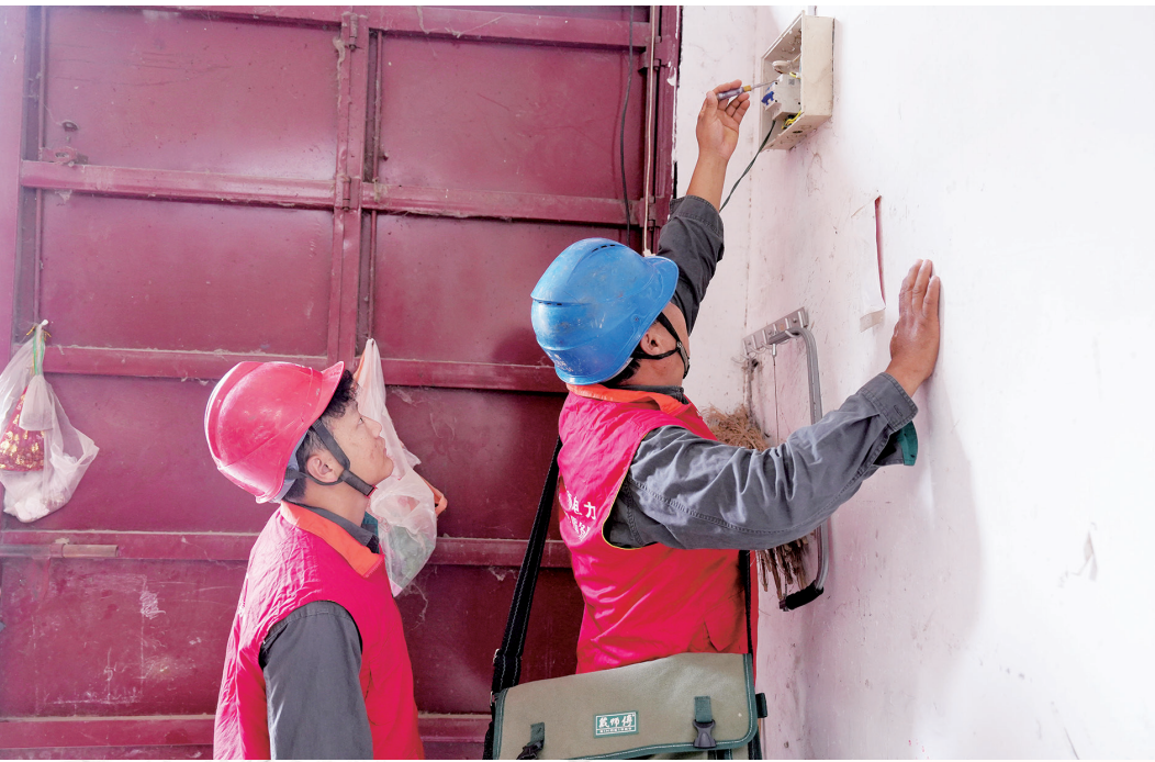
近日，息县供电公司组织白店中心供电所工作人员到用户家中开展安全用电检查，筑牢群众用电安全防线。
