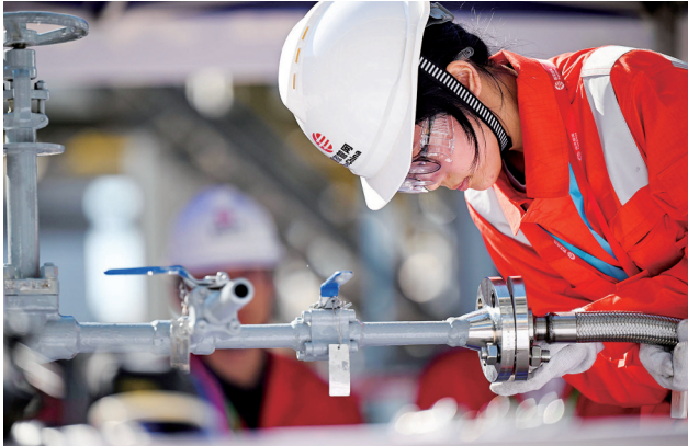
9月1日，在国家管网集团天津LNG接收站，参赛选手在比赛中。 9月1日，2026年全国石油石化行业液化天然气储运工职业技能竞赛在国家管网集团天津LNG接收站开幕。 新华社记者 赵子硕 摄
