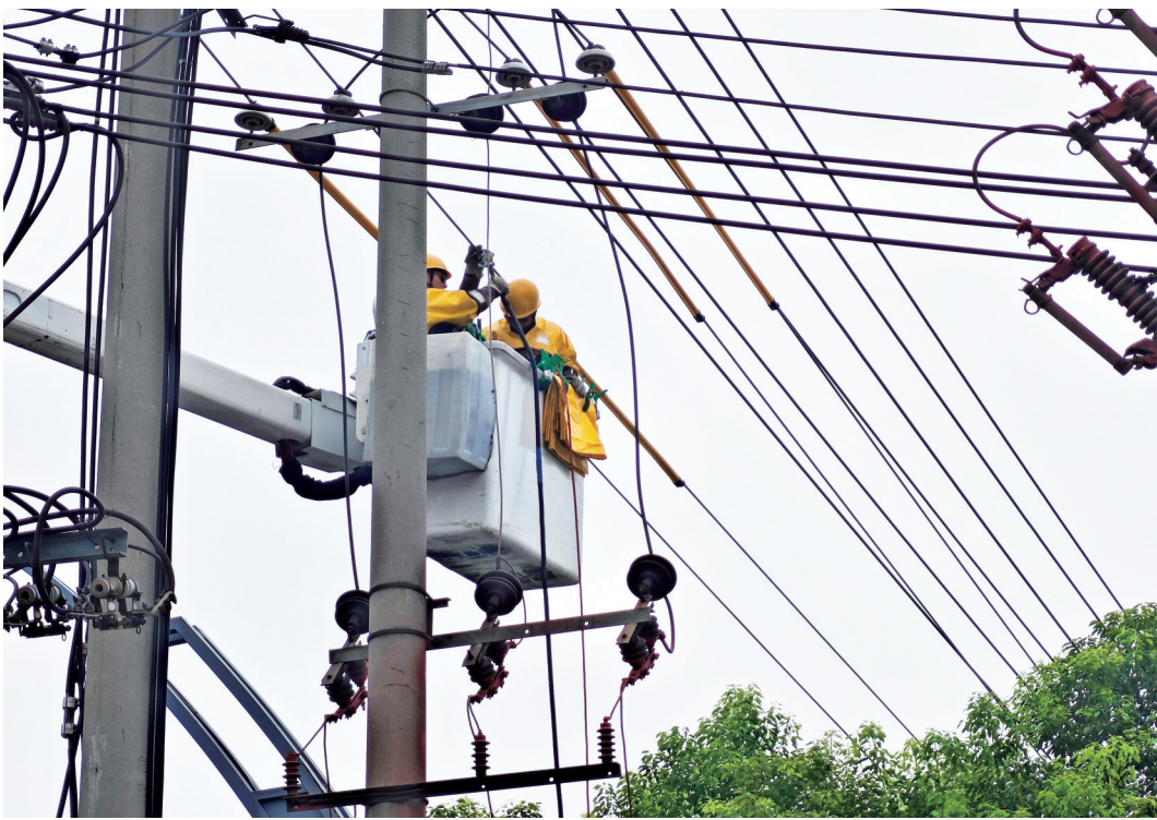
近日,息县供电公司带电作业班工作人员对息县儿童医院门口10千伏稻25板步行街线淮河路分支11号杆开展带电更换柱上变压器作业,确保沿街350户居民用电安全可靠。
