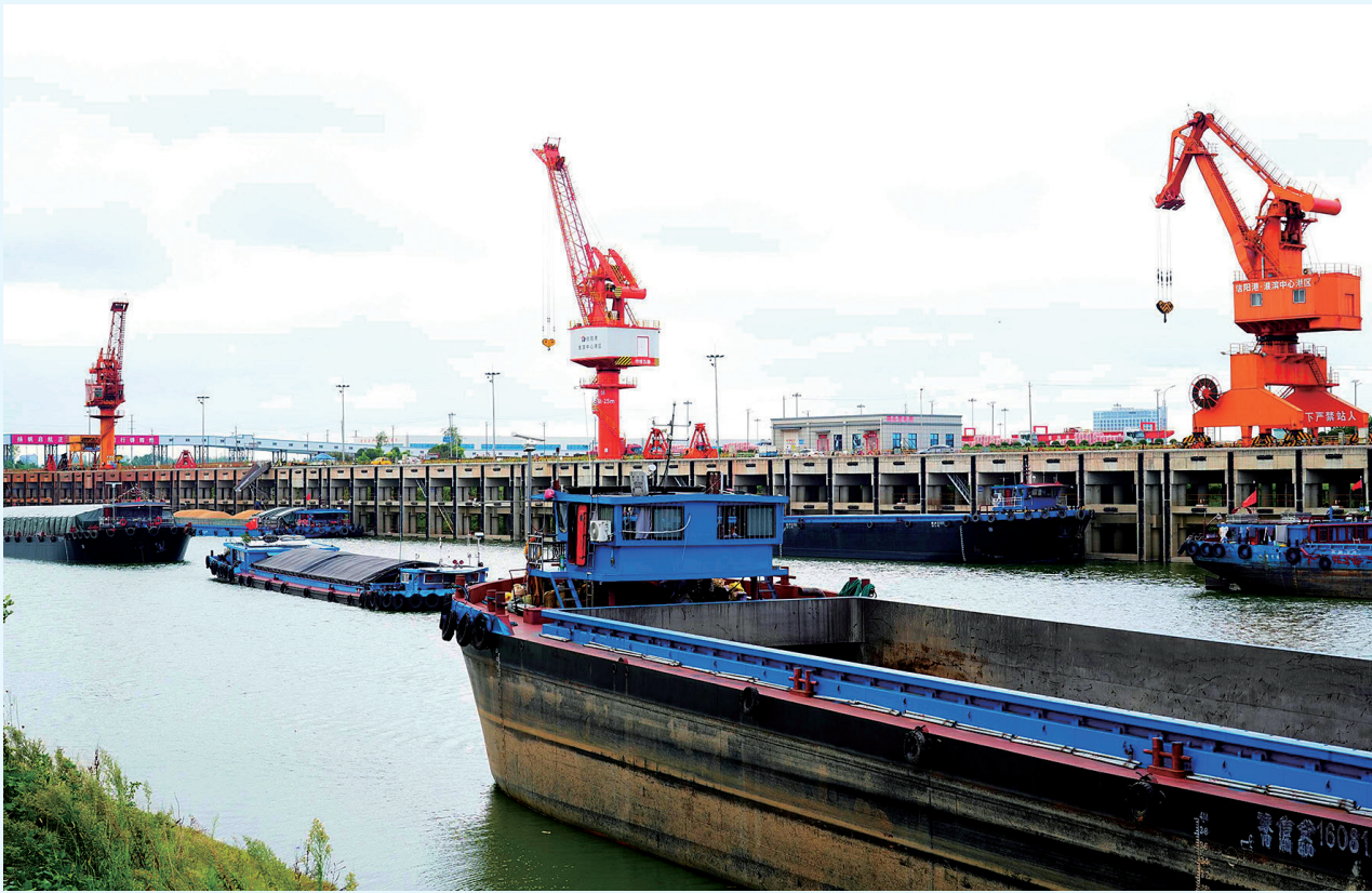
8月12日,信阳港·淮滨中心港抢抓作业窗口期,科学调配人力物力,高效开展水上货物转运作业,港区泊位船只有序停靠,岸吊轮番作业,货运车辆往来穿梭,石材、集装箱等物资加紧装卸转运,水陆联运一派繁忙景象。 王长江 摄
