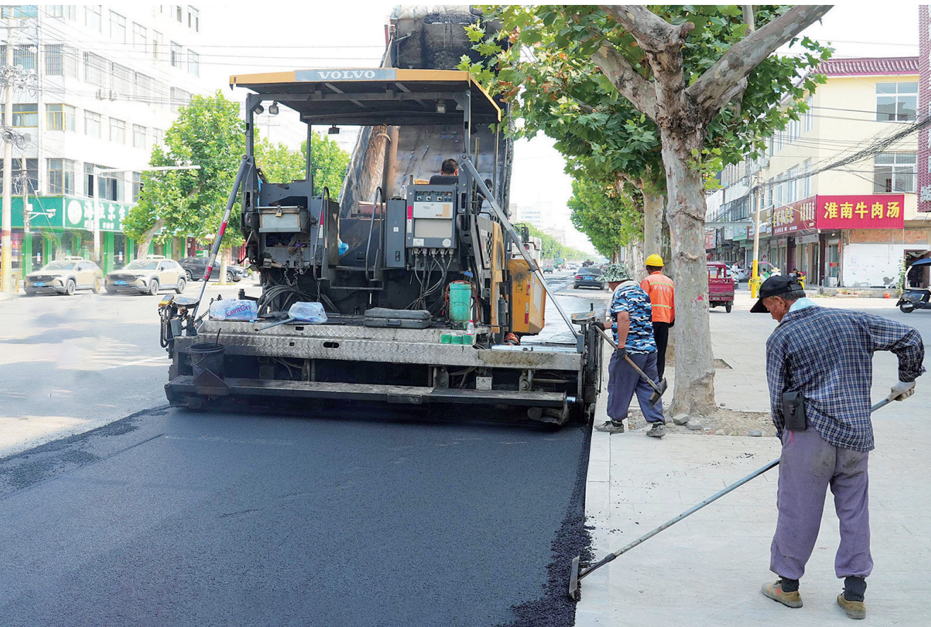
8月7日,淮滨县民政路南段施工现场,工程机械正在进行单侧柏油路面铺设作业。连日来,在淮滨县,广大建设者不惧高温酷暑,奋战施工一线,全力推进街巷提质、地下管网升级等项目,进一步完善城区路网,畅通城市交通微循环,便利群众出行。
