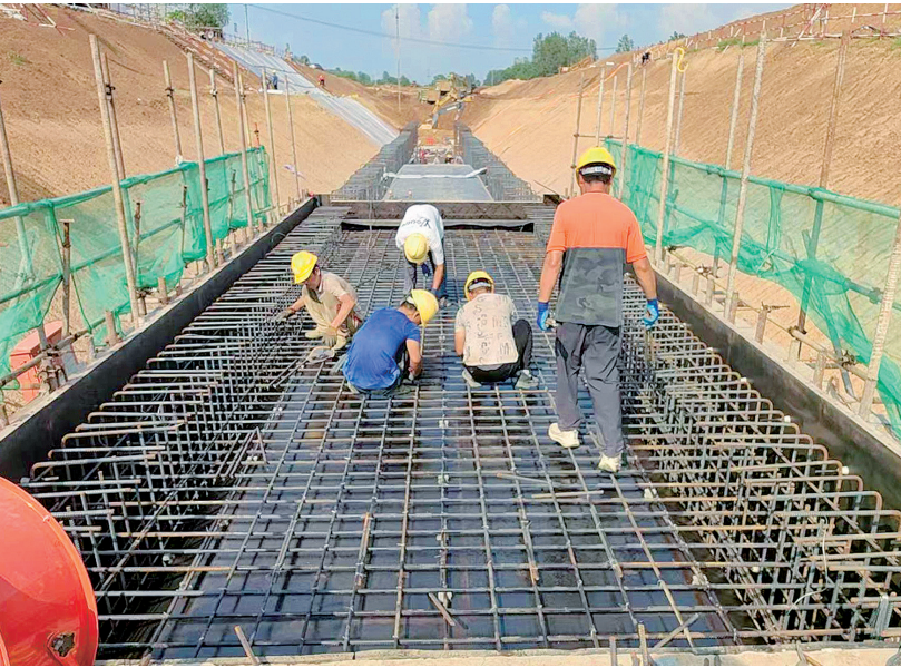
图为淮南千渠羊山新区彭家湾乡张岗村10#暗渠施工现场。熊辩 摄
