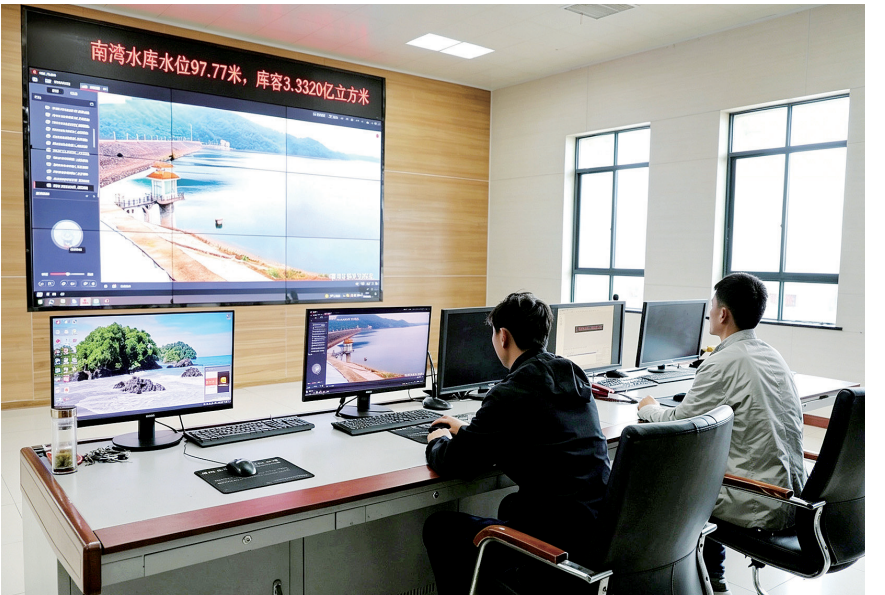
入汛以来，南湾水库事务中心监控中心实行24小时不间断值守，工作人员以精准监测、快速响应的实际行动，筑牢水库防汛“第一道防线”。图为7月17日下午，我市突降暴雨，值班人员密切关注水位和库容的实时变化。
