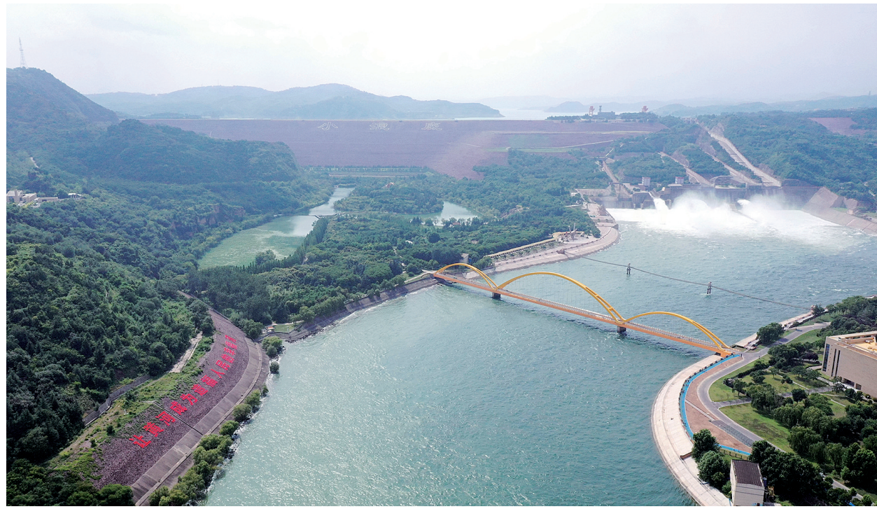
这是6月22日在河南济源拍摄的小浪底水利枢纽工程调水调沙现场(无人机照片)。6月22日，小浪底水利枢纽3条排沙洞闸门开启，黄河2026年主汛期前调水调沙随之启动，水库排沙量预计将超1亿吨。
