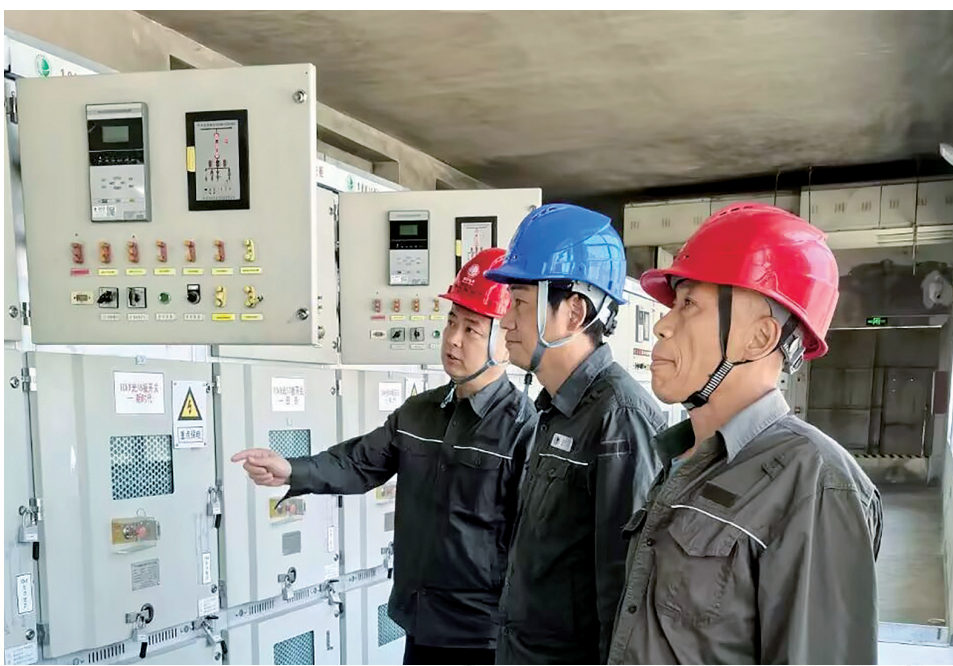
6月15日,光山县供电公司运维人员在负荷高峰时段开展变电设备特殊巡视工作,全面排查隐患,筑牢迎峰度夏保电防线,确保电网安全稳定运行。 张磊 摄
