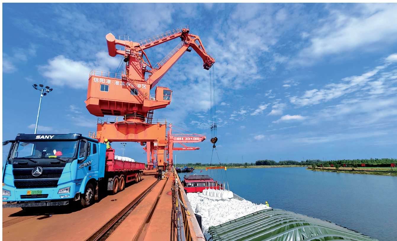
昨日,信阳港·淮滨中心港区码头一派繁忙,货物起重吊装作业有序开展。
