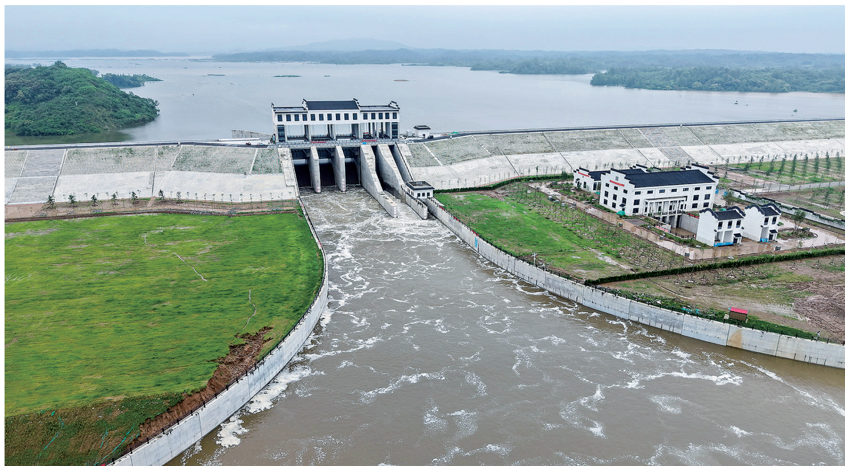
5月22日至25日,我市持续降雨,刚刚建成的袁湾水库水位从65.80米逐渐上升至67.46米。5月26日,按照省水利厅通知要求,水库开闸泄洪,目前水库水位回落到安全水位66.38米。 本报记者 郝光 摄
