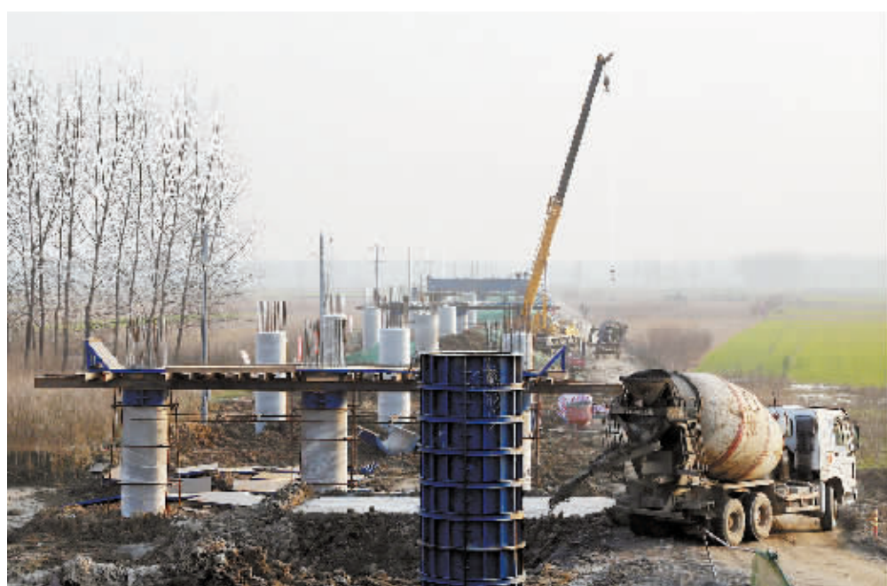
12月8日,工人正在为G328线淮滨段淮河公路特大桥项目进行盖梁施工。据悉,该桥全长2978.56米,桥面宽16米,总投资1.83亿元,预计2018年5月份建成通车。该桥建成后,对于完善周边交通网络,开发沿线资源,优化区域经济布局,带动群众脱贫致富具有重要意义。郝猛 夏训巍 摄
