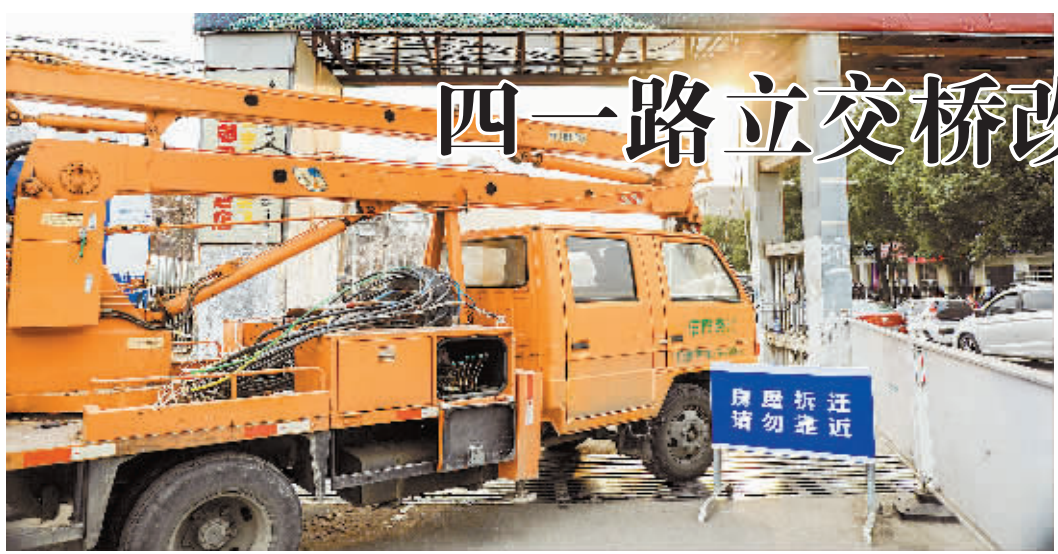
图为市区四一路立交桥改扩建工程现场。
