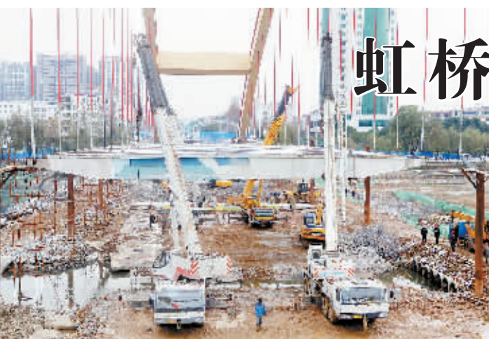
图为虹桥施工现场。
