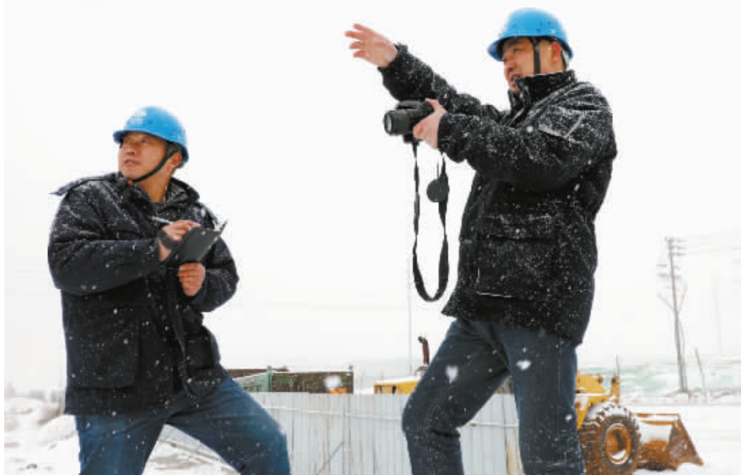
11月23日,信阳供电公司组织线路运维人员冒雪对辖区内220千伏洪双线等数条高铁供电线路开展特巡。运维人员现场检查了该线路覆冰、舞动情况,实地检查铁塔基础及其护坡防护措施,核实确无塌方现象。据悉,该公司运维人员还对线下机械施工情况全面排查,确保恶劣天气重要线路可靠供电。杨帆 摄
