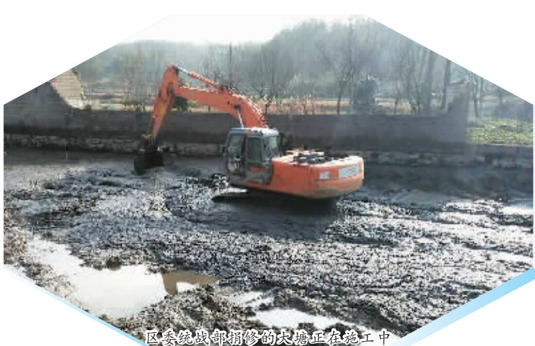
区委统战部修缮的大路正在施工中
