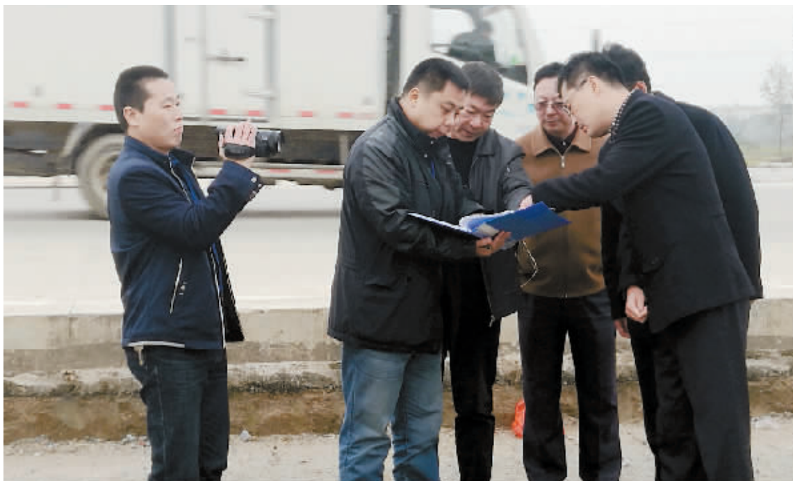
连日来,市大气污染防治攻坚战领导小组办公室督查组深入息县、淮滨县、潢川县和光山等多处建筑工地、拆迁工地,对堆场、道路施工等扬尘污染整治情况进行实地督查。图为督察组人员正在淮滨县迎宾大道对路面裸露情况扬尘情况进行督查。本报记者 孟磊 摄
