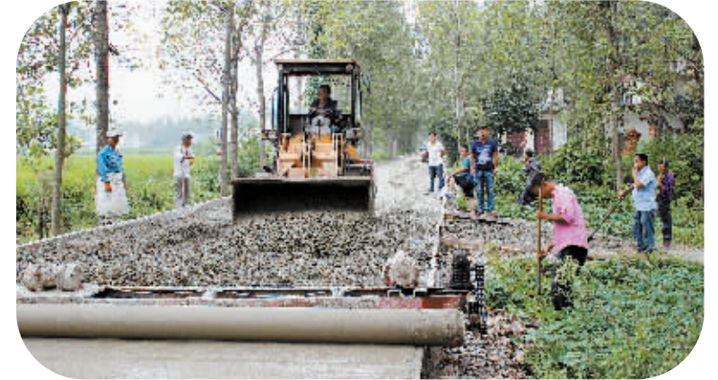
项目施工现场
