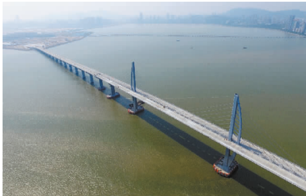
这是港珠澳大桥九洲航道桥的风帆造型桥塔(9月27日摄)。 9月27日,港珠澳大桥主体桥梁正式贯通。港珠澳大桥是连接香港、珠海、澳门的超大型跨海通道,全长55公里。
