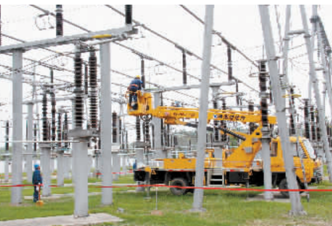
图为施工现场。
