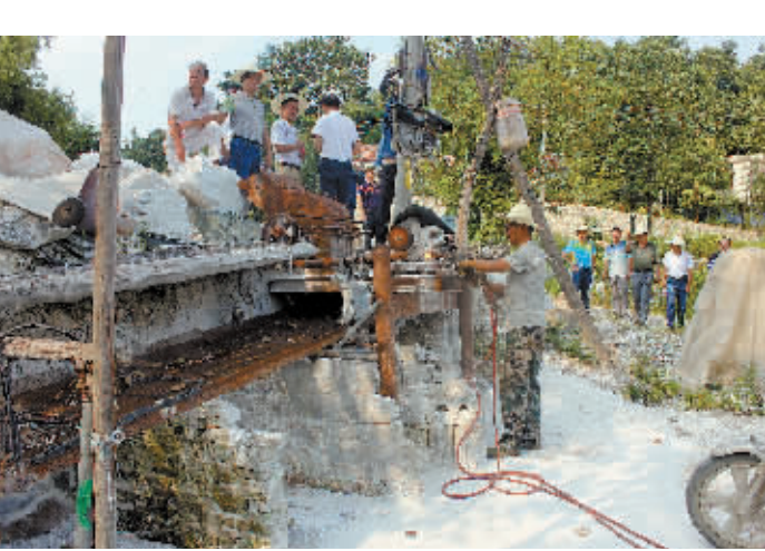
图为矾石厂主正在对机器进行拆除。 本报记者 黄宁 摄
