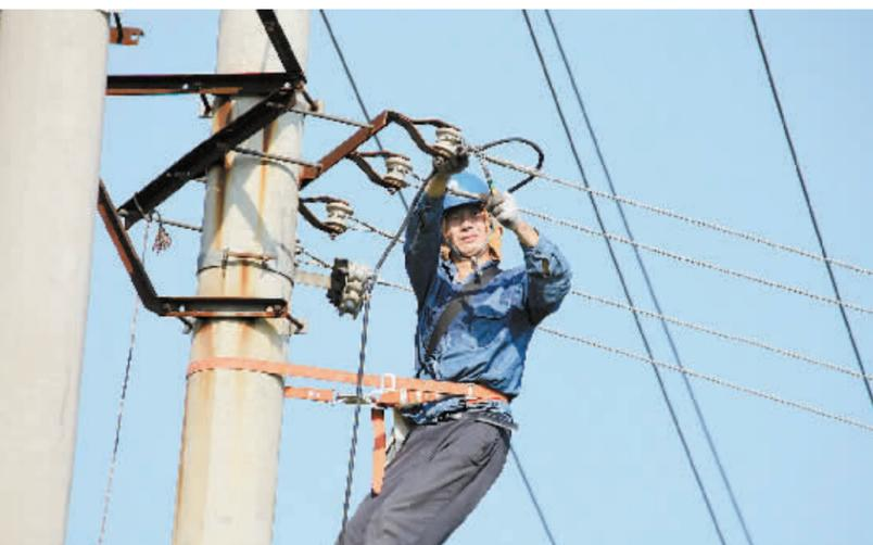
立秋后的新一轮高温,致供电负荷再创新高。为保障高温下的安全可靠用电,近日,潢川县供电公司组织员工冒着39℃的高温,对桃园七号台区实施增容工作,将该台区原有100千伏变压器增容至315千伏安。图为施工人员正在更换引流线。 杨君 摄
