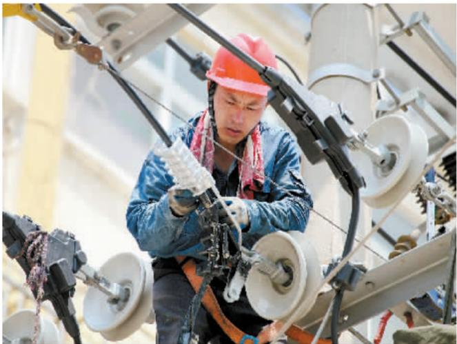
►7月31日,潢川县供电公司员工冒着40℃高温,连续奋战3个小时,对10千伏潢7线展开消缺工作。图为施工人员进行更换线路线夹。杨君 摄
