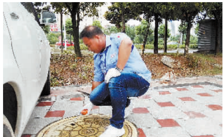
徐浩将检漏仪的金属探头伸进井下进行检测。 刘翔 摄
