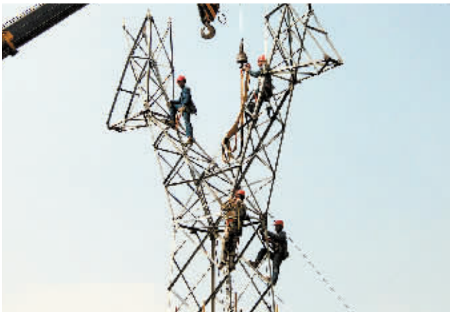
▲8月2日,息县供电公司组织施工人员成功完成3基铁塔组立。近日,由于受雨水的冲洗,息县110千伏桂息线27号塔基严重沉降倾斜。当天,该公司60余名工人连续工作16小时,下午6时,全部恢复正常供电。图为施工现场。 葛晓宁 摄
