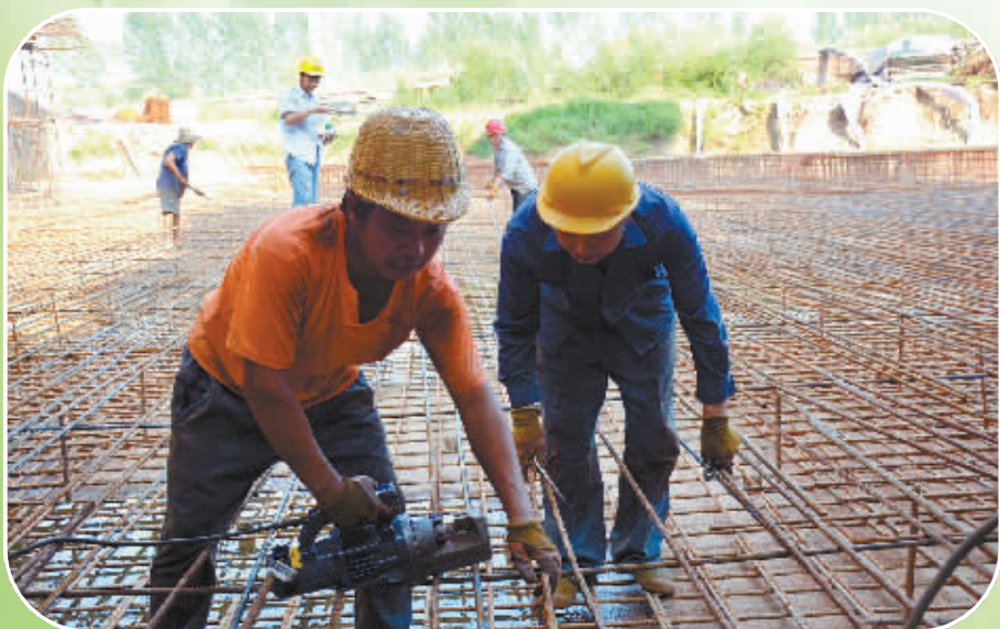
人物:王宪双 拍摄地点:107国道西侧某建筑工地
