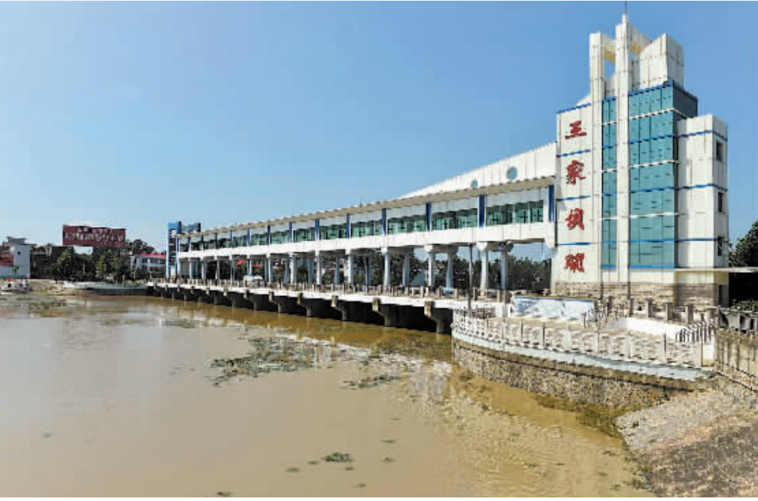
7月22日拍摄的安徽省阜南县王家坝坝。记者从淮河水利委员会了解到，7月22日1时王家坝水文站今年首次达到超警戒水位，发生淮河2016年第1号洪水，预计22日20时最高水位可能达到27.9米，超过警戒水位0.4米，安徽省将面临长江、淮河防汛抗洪双线作战的压力。
