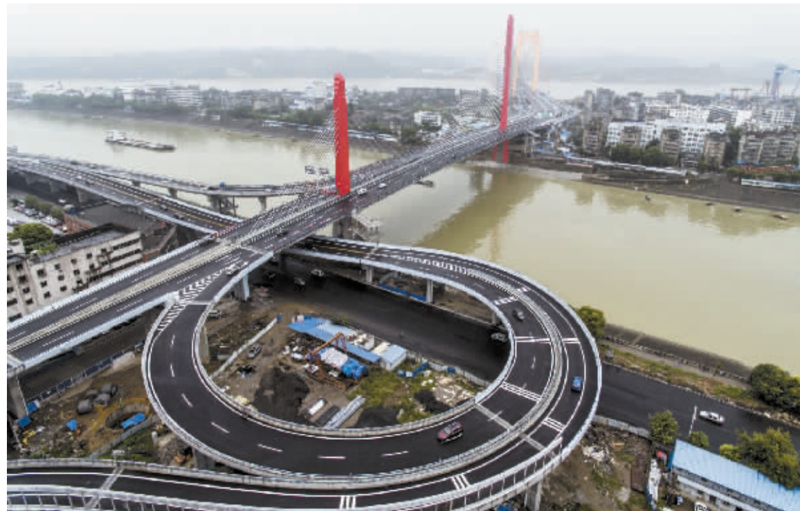
7月18日,至喜长江大桥建成通车。当日,湖北宜昌至喜长江大桥建成通车。中铁大桥局采用多项新技术建设的至喜长江大桥主跨838米,为单跨地锚式悬索桥,双向六车道。新华社记者 肖艺九 摄
