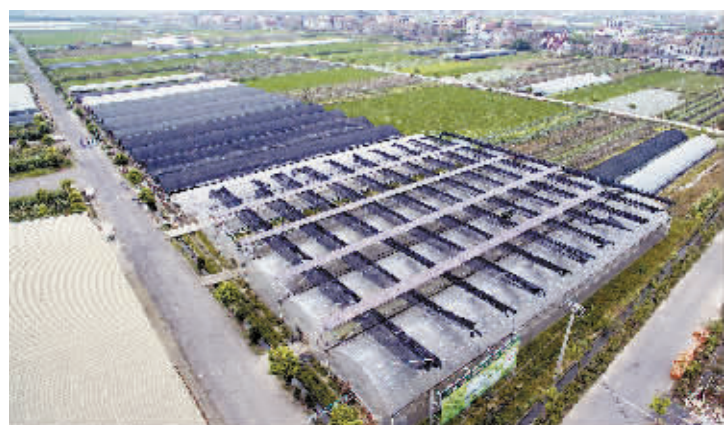
杭州市萧山区益农沙地绿色纯品瓜果蔬菜试验场育秧大棚顶上的光伏设备(7月14日摄)。近年来,浙江光伏项目全面“开花”,除了厂房屋顶光伏,居民屋顶光伏,在农田蔬菜大棚、鱼塘、社区菜场等处都可见光伏设备。 (新华社杭州7月14日电)
