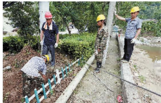
田铺乡变压器线杆根基被掏空,电力工人对杆子进行扶正回填加固,确保电力的畅通。 本报记者 郝光 摄
