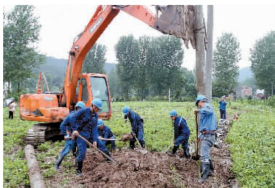
图为电力抢修队正在竖起并加固严重倾斜的电杆。
