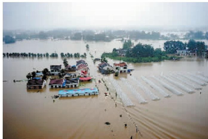
7月5日,搜救人员在被淹的舒城县柏林乡蔡家店村巡查。自6月30日开始,安徽省舒城县遭受大到暴雨袭击,目前全县河堤溃口达1000多处,造成国道、村庄、房屋、农田等损毁严重,全县受灾人口达30万人。面对洪涝灾害,舒城县正全力组织防汛抗洪和抢险救灾工作。
