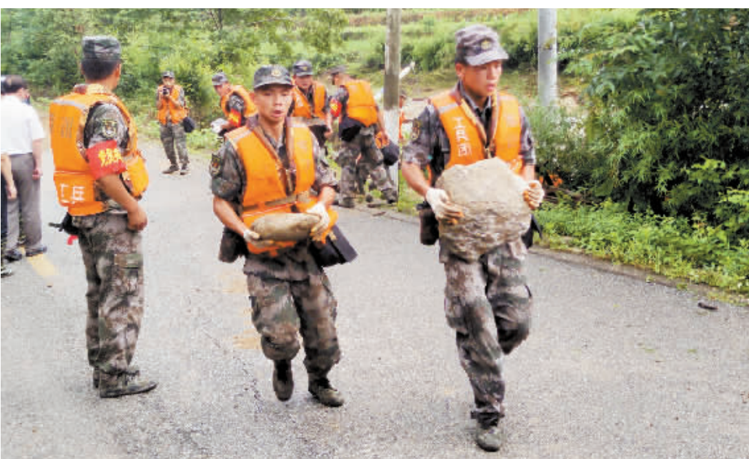
为迎接可能发生的新一轮降雨,防止次生灾害发生,昨日,驻信某工兵团组织100多名官兵,在新县田铺乡道路塌方地段堆石抢修,构筑安全道路防线。图为抢修现场。 本报记者 黄 铎 摄
