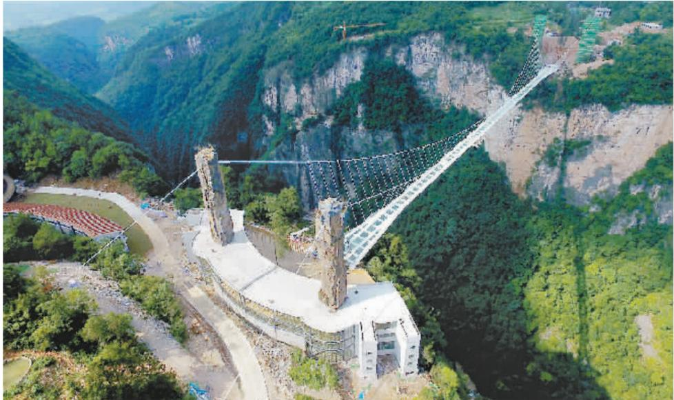
航拍的张家界大峡谷玻璃桥(6月23日摄)。近日,湖南张家界大峡谷人行玻璃桥完成桥梁施工,对外开放在即。据悉,张家界大峡谷玻璃桥总长430米、宽6米,桥面距离谷底相对高度约300米。桥面全部采用透明玻璃铺设,最大游客容量为800人。
