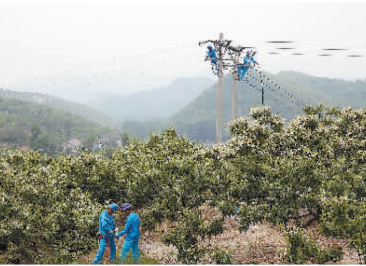
6月17日，国网河北省青龙满族自治县供电公司工人在辖区鞍池子村供电线路改造升级现场施工。
