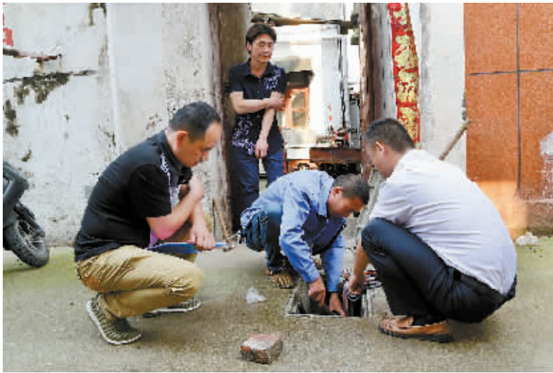
图为党员志愿者正在为困难户维修水表
