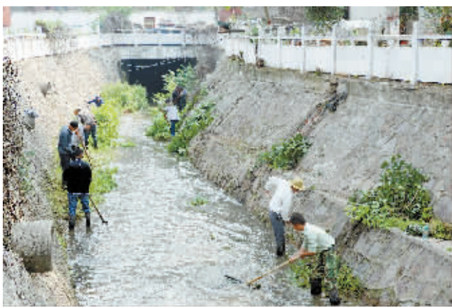
近期,浉河区湖东街道办事处组织人员,对辖区三里店河、湖东沟进行二次清淤,重点对河道内杂草、淤泥等阻水物进行清理,确保河道通畅,提升了辖区内河防汛排涝能力,确保辖区安全度汛。 丁宁 摄
