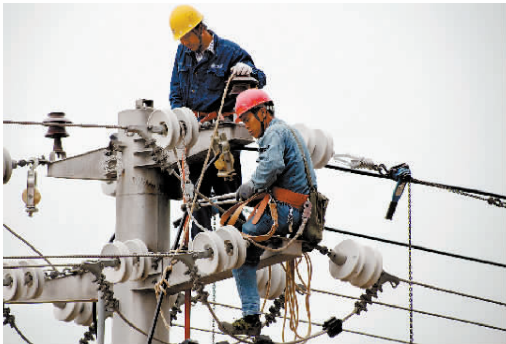
5月21日起,潢川县供电公司80余名电力工人利用3天时间,圆满完成该县城区配网10千伏定9、定10线改造工程,进一步优化了该县城关区域配电网架结构,为线路设备在迎峰度夏期间安全可靠运行提供了保障。 李昊益 摄
