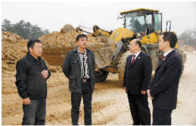
为有效预防扶贫领域职务犯罪,今年以来,商城县检察院重点对全县5个扶贫建设项目开展了工程建设同步预防,为打赢脱贫攻坚战提供有力保障。因为近日该院干警到扶贫建设项目施工现场开展同步预防时的情景。杨秋村 刘东辉 摄
