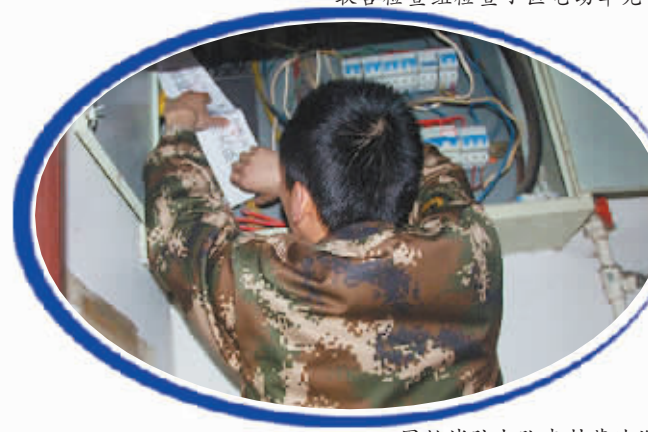
固始消防大队查封某洗浴中心
