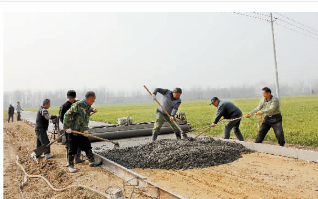
“正造林”文明信阳 新闻摄影大赛 潢川县双槐镇双槐村整村推进项目的道路修建现场,工人们正在进行混凝土平整。2015年以来,双槐镇通过重点推进基础设施建设、乡村风貌改造、民生保障建设等扶贫开发项目,拓宽群众脱贫致富路。截至目前,该镇成功实现两个村共1162人脱贫。
