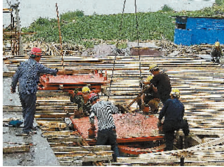
东京大桥施工现场(资料图)
