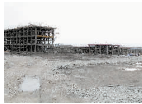
正在建设中的明港机场
