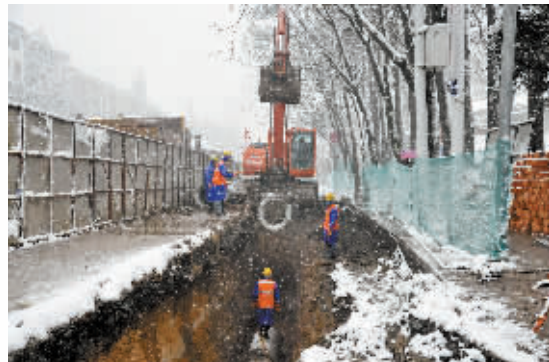
图为工人顶着风雪正加紧施工。马保群 摄
