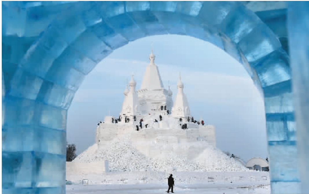
12月24日,在太阳岛雪博会园区内,雪雕技师在对雪塑建筑“冰雪之冠”进行雕塑。当日,在第28届哈尔滨太阳岛国际雪雕艺术博览会园区内,雪塑建筑“冰雪之冠”正在加紧雕塑中,预计将于2016年初完工。该建筑高达51米,占地面积2800平方米,用雪量约为3万立方米,将被打造成世界最高雪塑建筑。 新华社记者 王建威 摄
