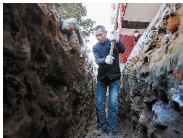
12月18日,淮滨县自来水供水管网改造工程施工现场工人正在紧张施工。近年来,随着城区和人口规模不断扩大,用水量急剧增长,加上南城区和西城区局部供水管网安装于上世纪80年代,布局也不尽合理,供水矛盾日渐突出。为尽快解决这一矛盾,淮滨县委、县政府将此作为2015年重点工作,大力推进城区供水管网改造工程,投资400万元,改造3条街巷供水管网,提升供水质量。 本报记者 郝光程 云摄
