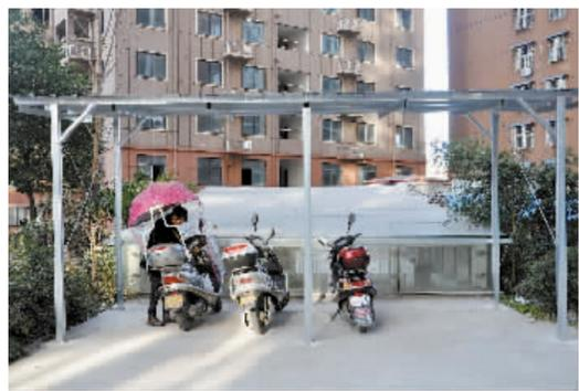
为有效预防和减少电动自行车充电引发的火灾事故,切实加强火灾防控工作,我市一些小区按照要求改造和建设电动车车棚和智能充电站。图为弘运阳光城市花园在建的智能充电站。据物业人员介绍,目前该小区增设至少4处智能充电站,路面硬化和输电线路铺设已初步完成。
