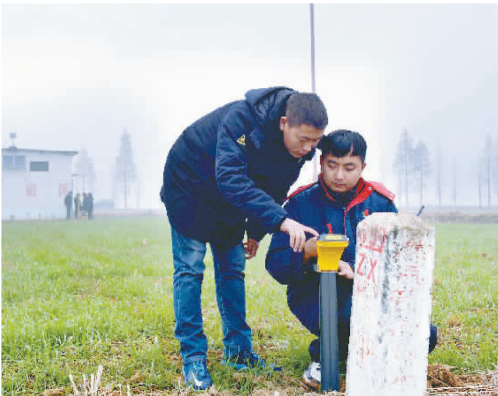
12月8日起,信阳富地燃气公司连续3天集中巡查市区外近100公里燃气管道,确保冬季供气正常。图为该公司巡线员在平桥区胡店乡一处间室周边巡查燃气管道。 马童 摄
