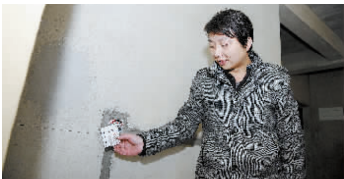
图为验房师肖先生正在毛坯房里对房屋电线布置进行测试。本报见习记者 张延合 摄
