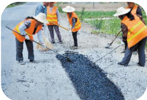
养护工人正在修复县乡公路破损路面。
