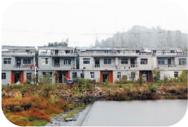
环境优美,设施完善,交通便利的新集镇金河村一角。
